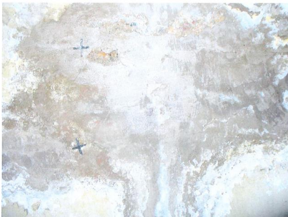
F4. Detail stropu po očištění výluhů
