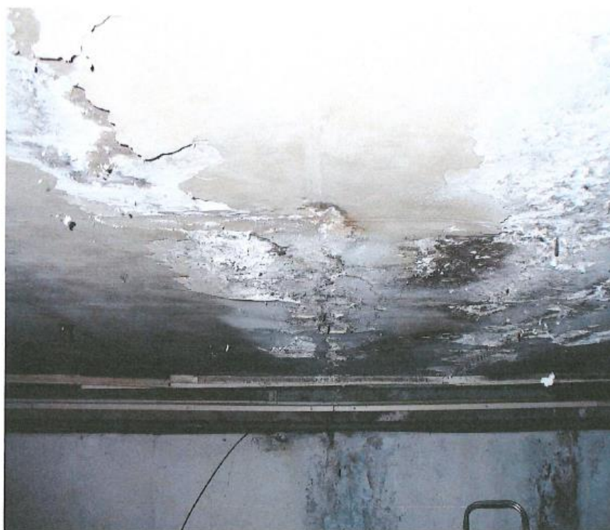
F2. Výluhy na stropní desce v krajním poli
