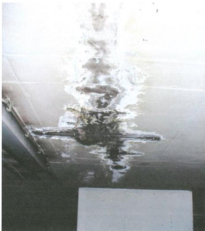
F3. Poruchy na stropě ve vnitřním poli
